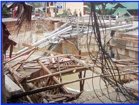
Das war mal eine Brücke
